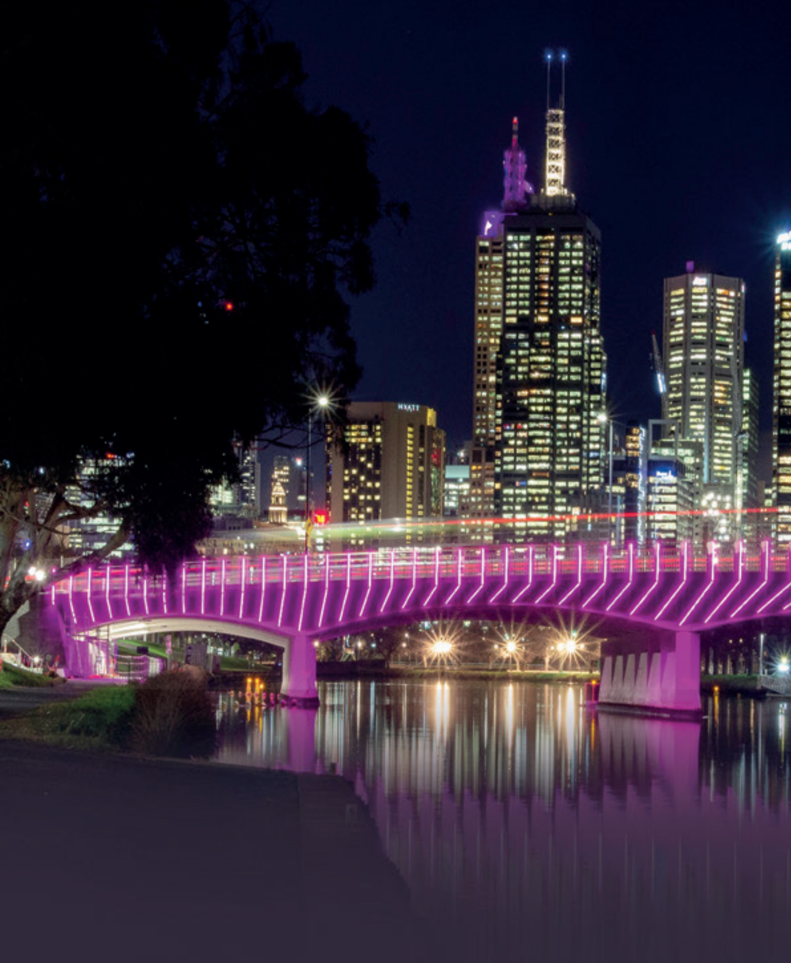
Swan Street Bridge, Melbourne, Australia Iluminado por Coolon LED Lighting Diseño de iluminación: Relume Consulting Arquitecto: BKK Arquitectos
